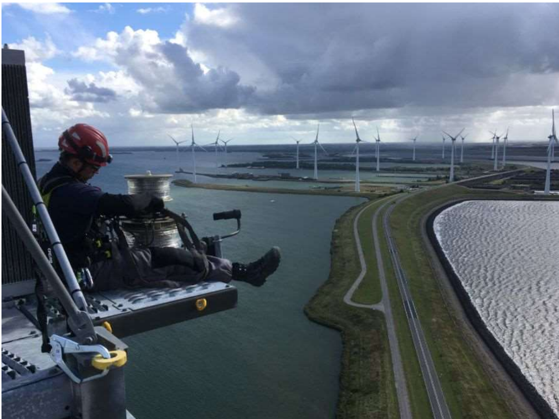
Monteur vervangt verlichting windturbine Windpark Krammer (foto: Windpark Krammer)
